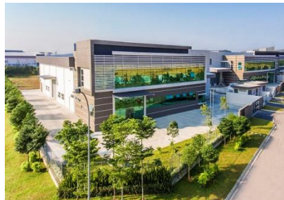
Gambar 5 : Ruang penanaman pada perimeter bangunan untuk mewujudkan kesan estetik yang tinggi pada kawasan.
